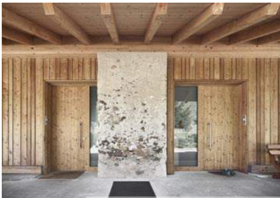
Nella pagina a fianco, veduta da nord-ovest del fienile restaurato e, sullo sfondo, il paese di Andriano sulla parte opposta della vallata. Sopra, particolare dell'ingresso a due appartamenti. Al centro, un reperto della parete originale in pietra e argilla.
