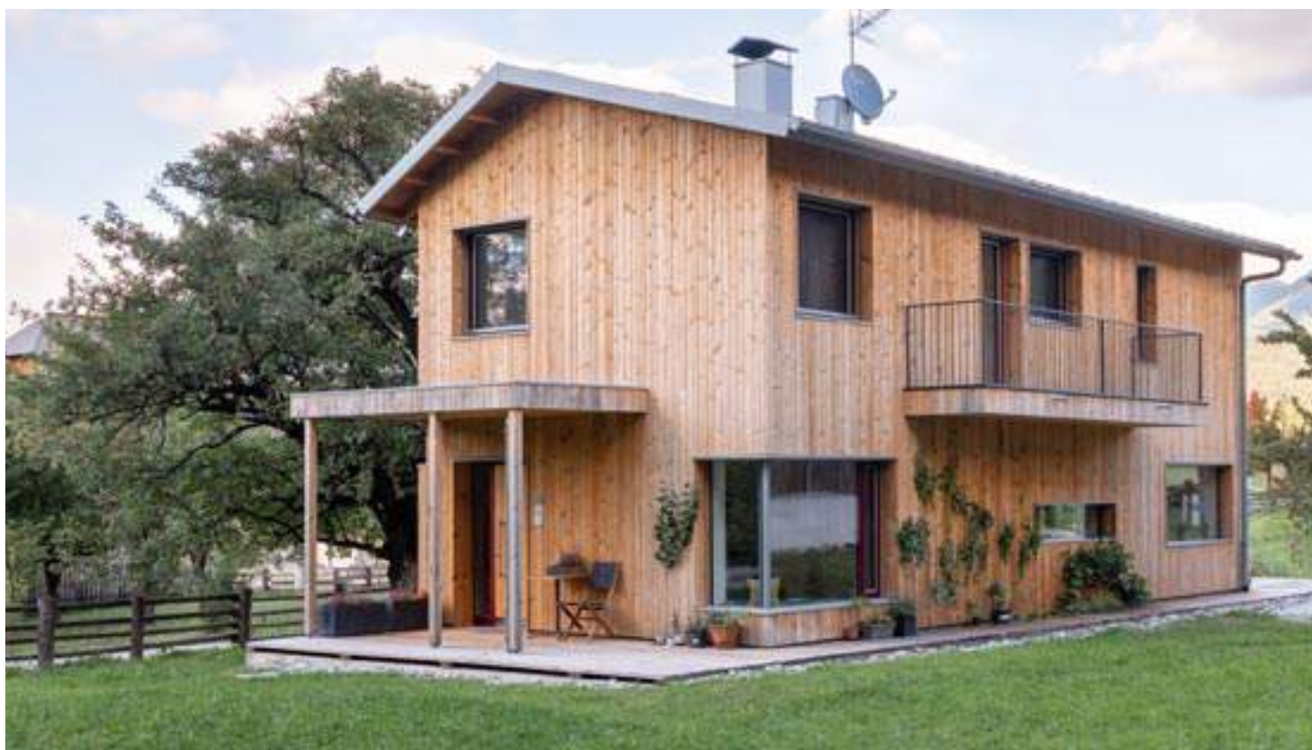
Vista da sud-ovest dell'edificio.
