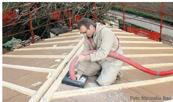
Mit Zellulose gedämmtes Dach
