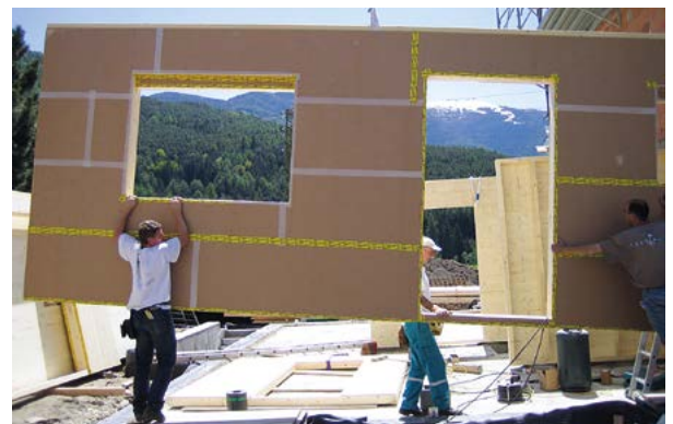
Montage einer gedämmten Holzrahmenwand
