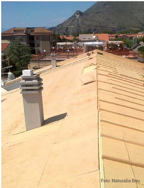
Dachdämmung mit Holzfaser
