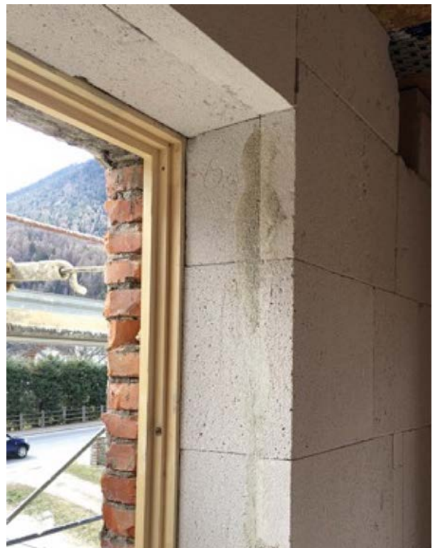
Innendämmung mit Mineralschaumplatten
