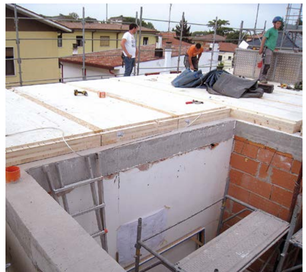
Sanierungsmaßnahme mit Aufstockung aus Holz
