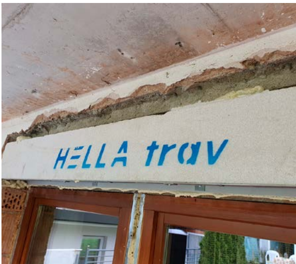
Einbau eines neuen gedämmten Kastens
