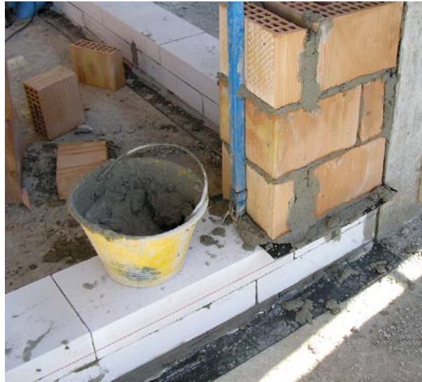
Dämmung unter dem Mauerwerk in Höhe der ersten Geschossdecke
