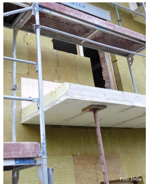
Dämmung des Balkons
