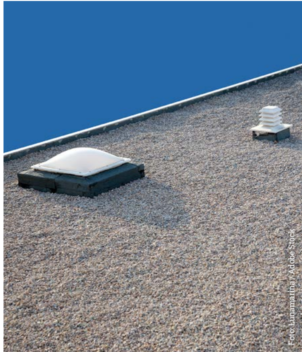
Mit Kies bedecktes Umkehrdach
