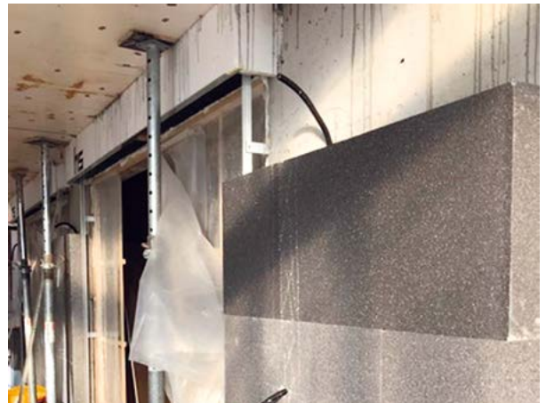
Einbau des gedämmten Rollladenkastens
