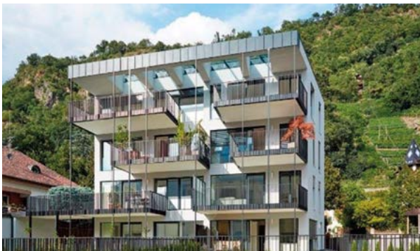
Horizontale Auskragungen in einem Mehrfamilienhaus KlimaHaus A, Meran
