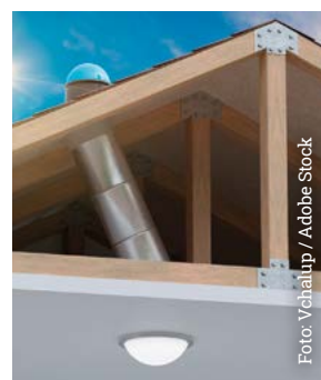
Durch den Dachboden geführter Sonnentunnel
