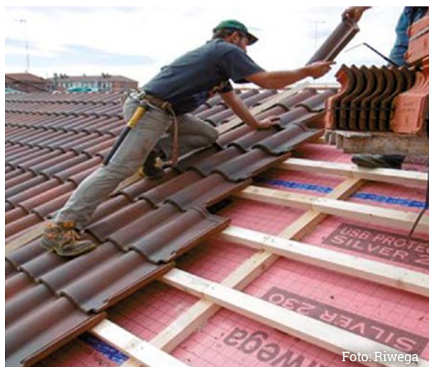
Verlegung der Dachziegel
