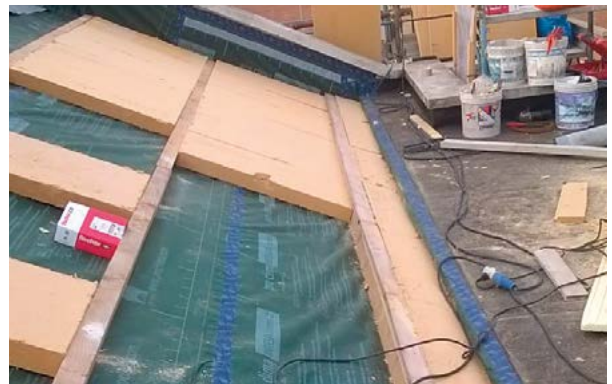
Dämmung der Eindeckung mit Holzfasern
