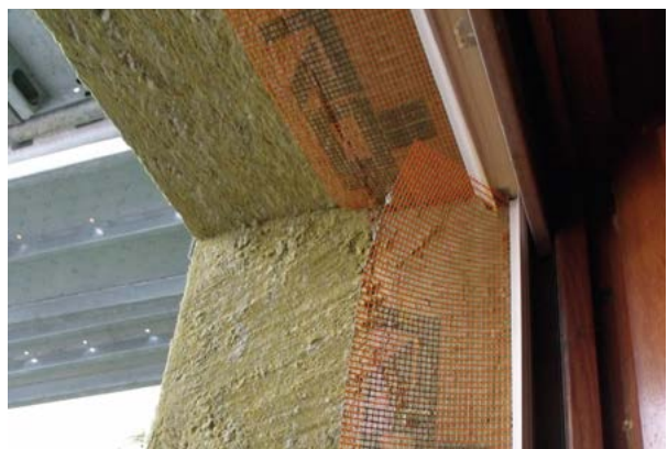
Dämmung der Fensterlaibung
