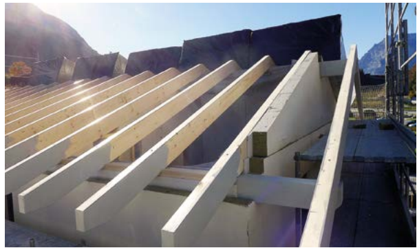
Montage eines vorgefertigten Holzdaches
