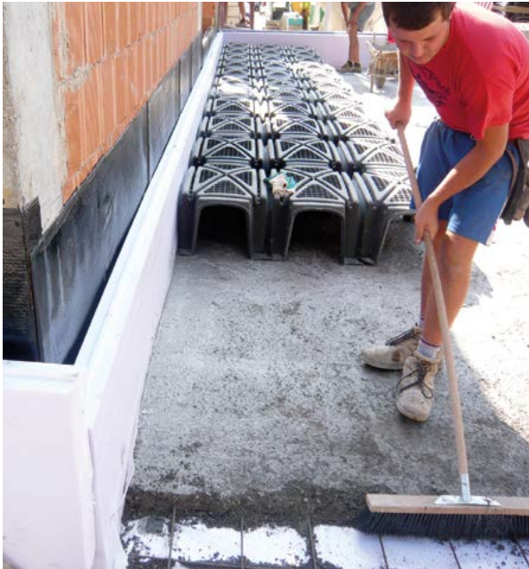
Abdichtung der Außenwand
