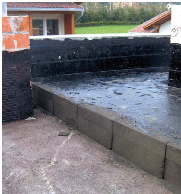
Dachabdichtung und Dämmung mit Schaumglas
