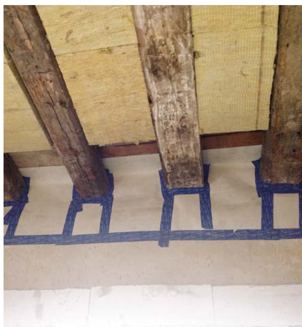
Zwischensparrendämmung
