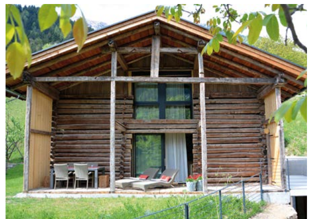
Blockhausstruktur eines wiederaufgebauten Bauernhofs in KlimaHaus-Bauweise im Passeiertal (BZ)
