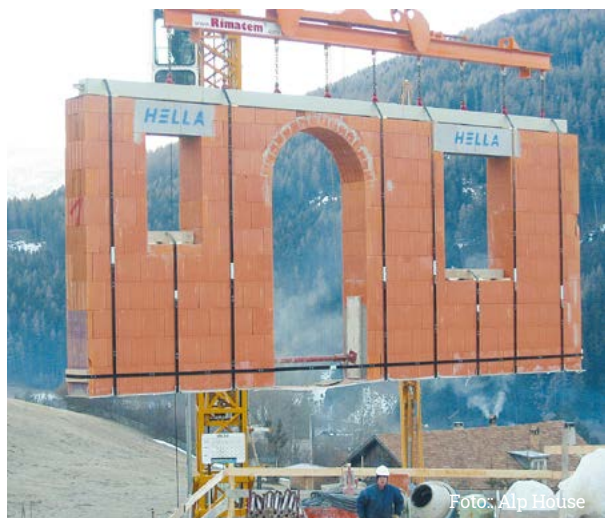
Fertigmauerwerk für Fertighäuser in massiver Ziegelbauweise
