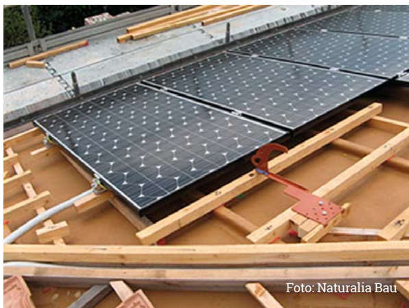
Dach mit integrierter Fotovoltaikanlage
