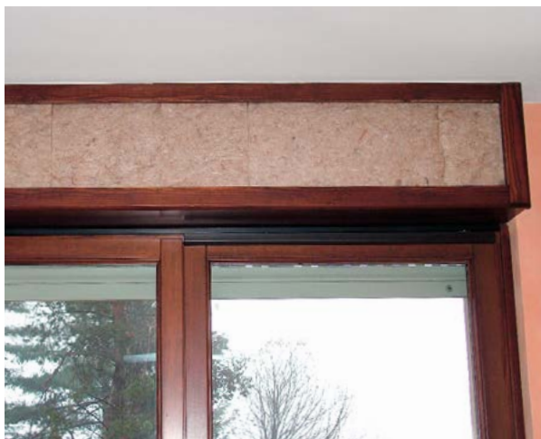
Gedämmter Rollladenkasten
