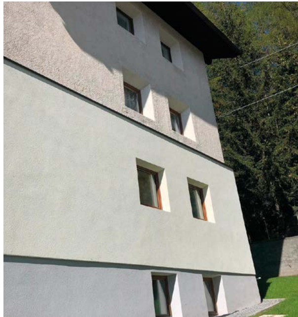
Maßnahme zur Teilsanierung
