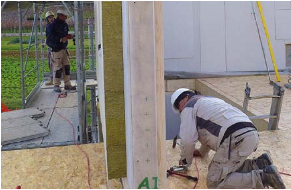
Holzrahmenwand mit außen angebrachter Mineralfaserdämmung
