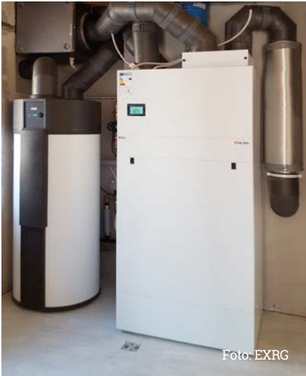
Kompaktaggregat mit zusätzlichem Wärmepumpen-Boiler
