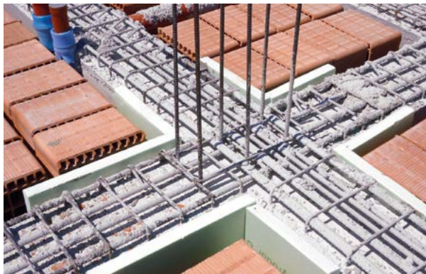
Fundamente mit umgekehrten Balken
