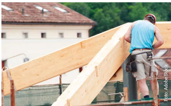
Struktur aus Brettsperrholz
