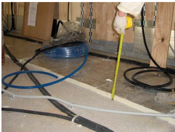
Dämmung der Bodenplatte
