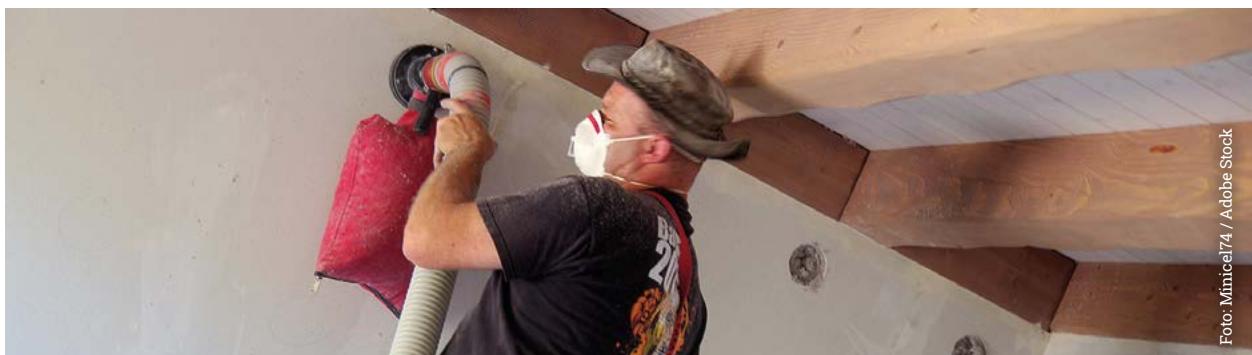
Insufflationsverfahren zur Dämmung im Hohlraum
