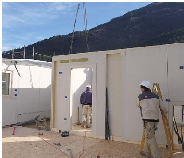
Montage von vorgefertigten Holzrahmenwänden mit Beplankung aus Gipsplatten
