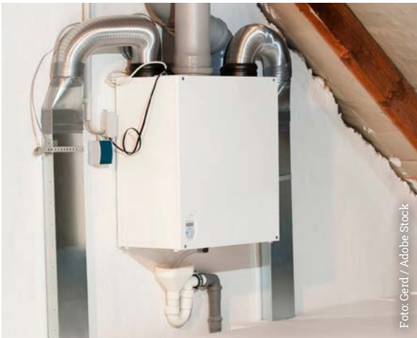
Installierte Wohnraumlüftung
