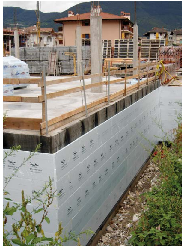
Wand gegen das Erdreich, mit XPS gedämmt
