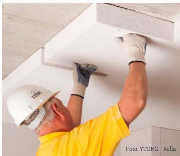
Dämmung der Decke zu unbeheizten Räumen mit Porenbeton
