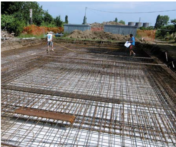
Fundamentdämmung mit XPS
