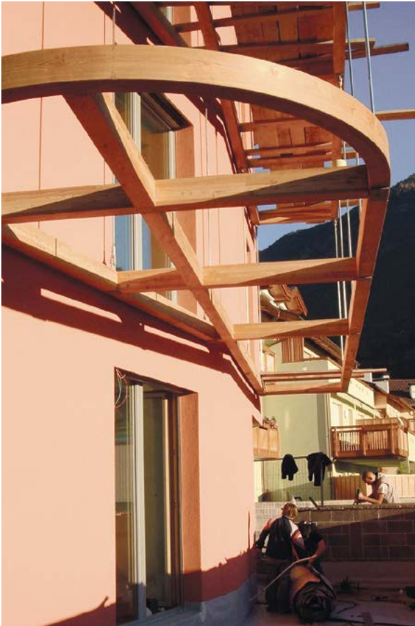
Konstruktion eines Balkons mit Außenstruktur
