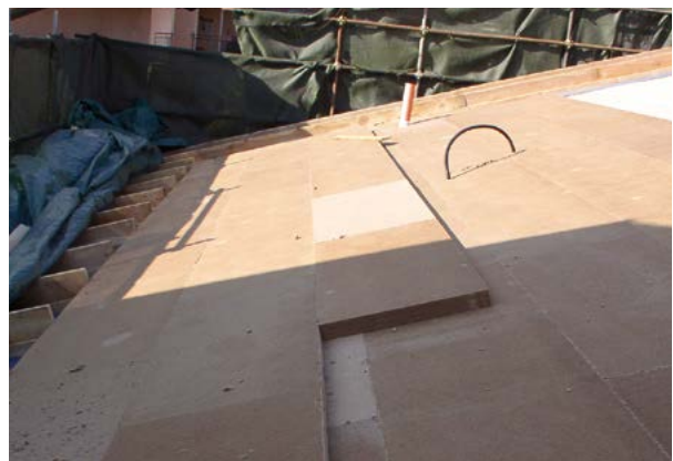
Dämmung oberhalb der Sparren
