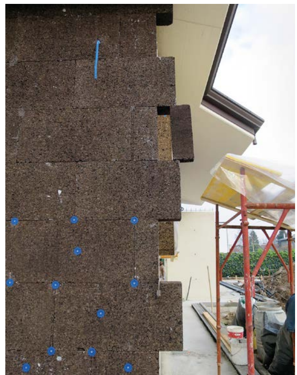
Kork-Wärmedämmung, Ecklösung
