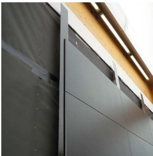
Detail einer hinterlüfteten Fassade
