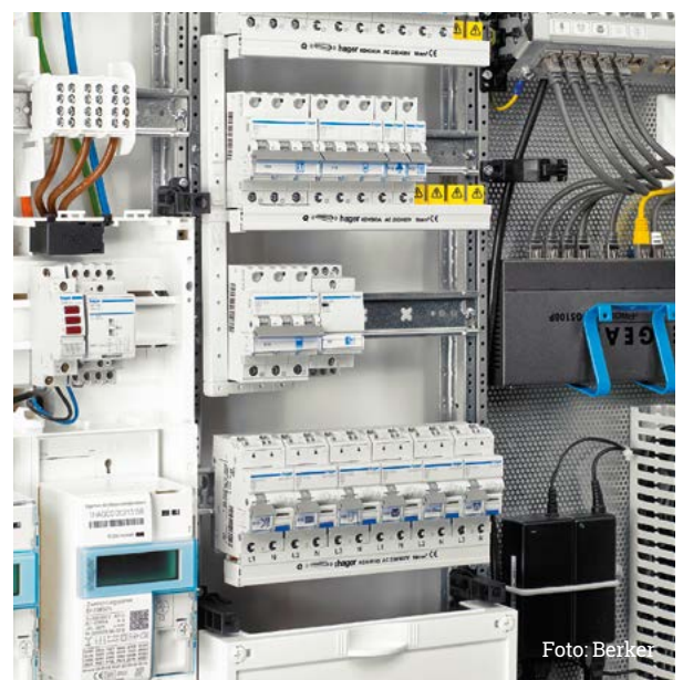
Hauptsicherungskasten
