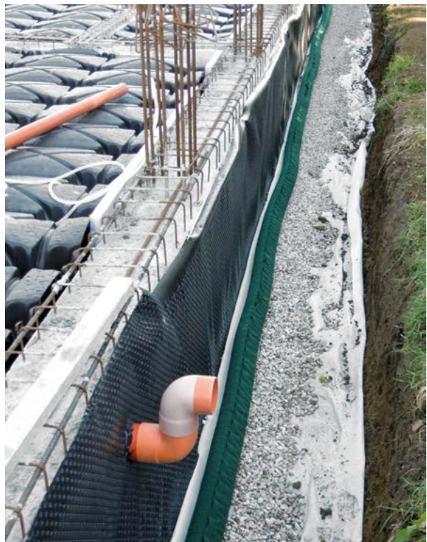
Fundament mit belüftetem Hohlraum und Außenabdichtung
